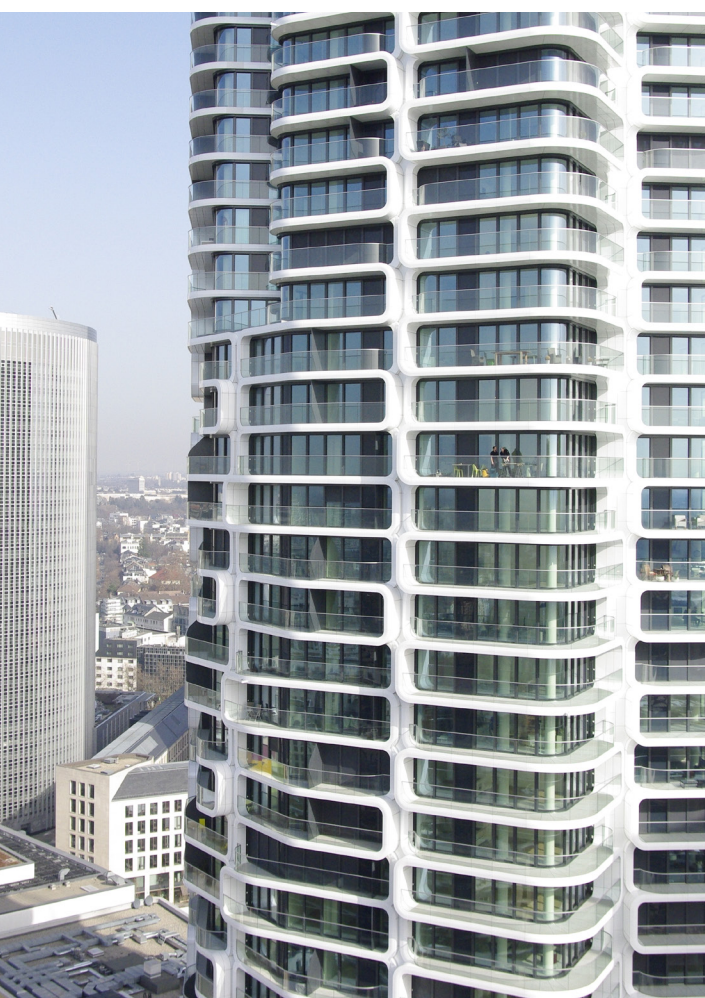
Sehr hoch, besonders geschützt: Der Grand Tower hat außenliegende Sonnenschutz an der Fassade
