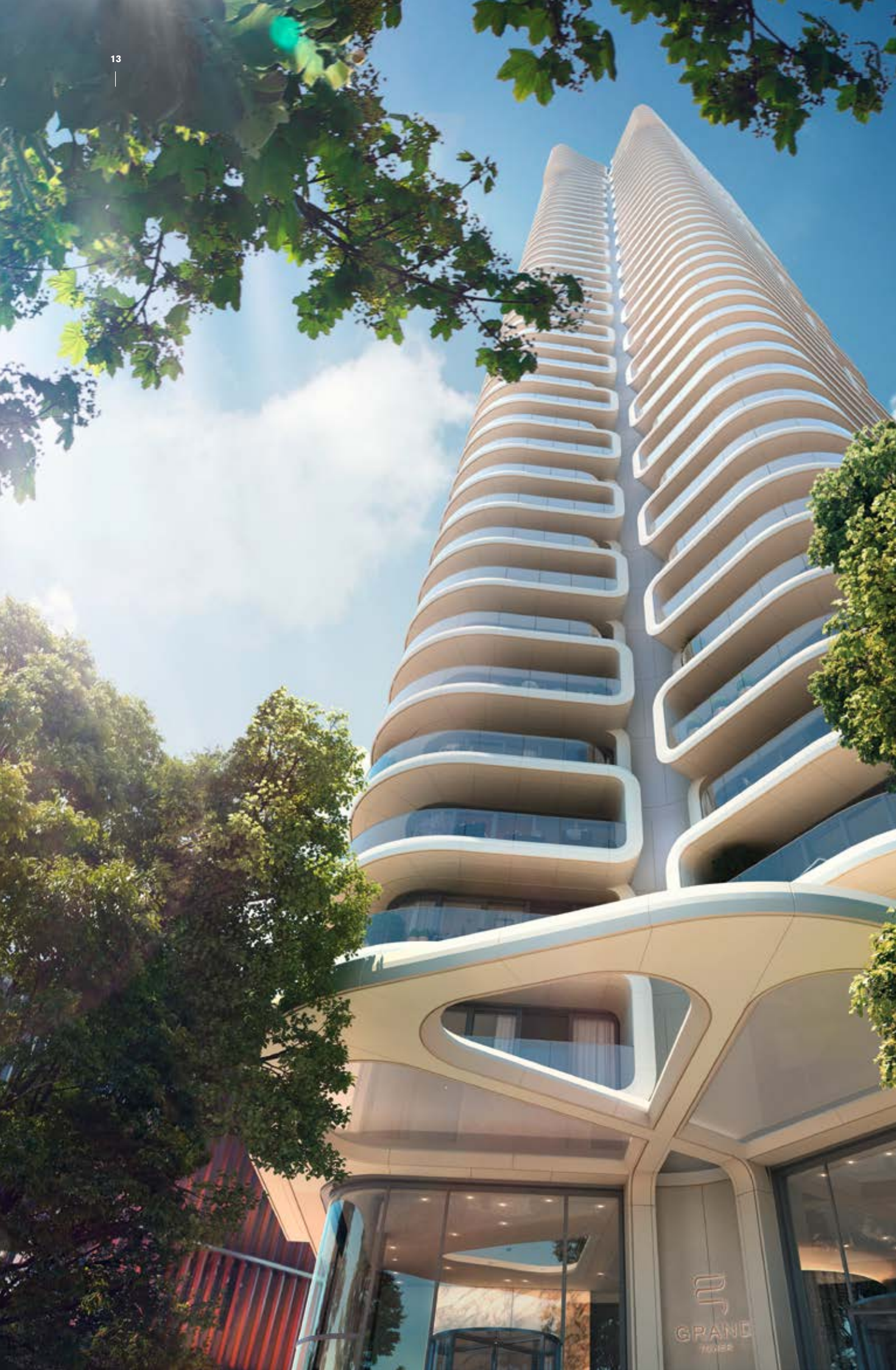
Versetzt angeordnete Loggia-Elemente bestimmen das Design der Fassade und den einzigartigen Look des Towers. Loggias juxtaposed on alternate floors create an out-of-the-ordinary façade and ensure a high-rise of unique appearance.
